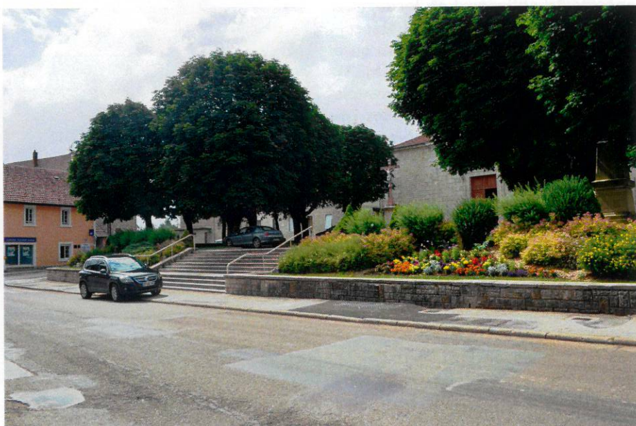
Aménagement d'une rampe d'accès sur le côté
