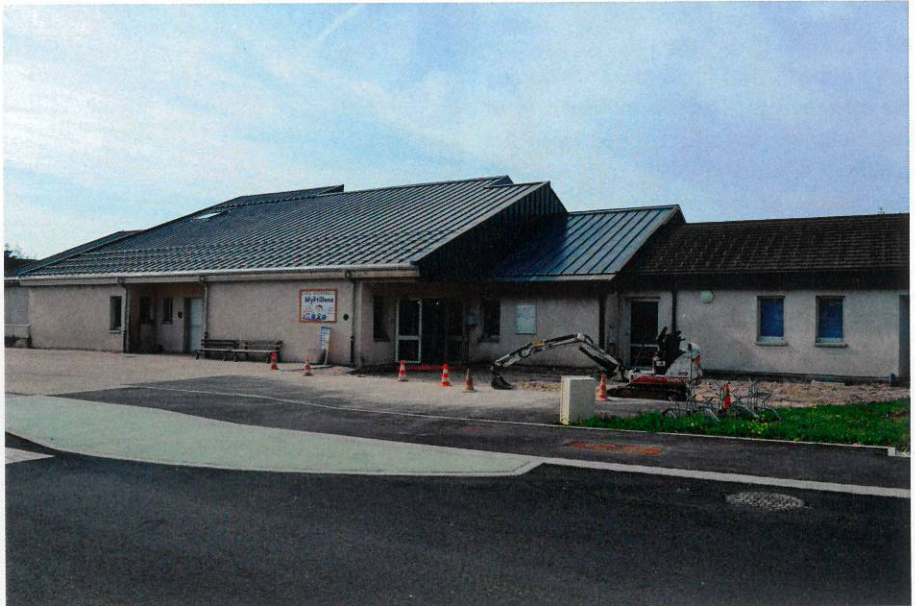
Ces travaux engendreront près de 60% d'économies d'énergie
