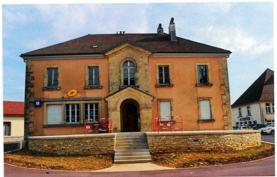
Les gardes corps seront installés prochainement
