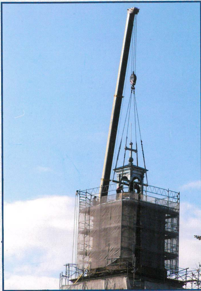
Mise en place du nouveau clocheton.
