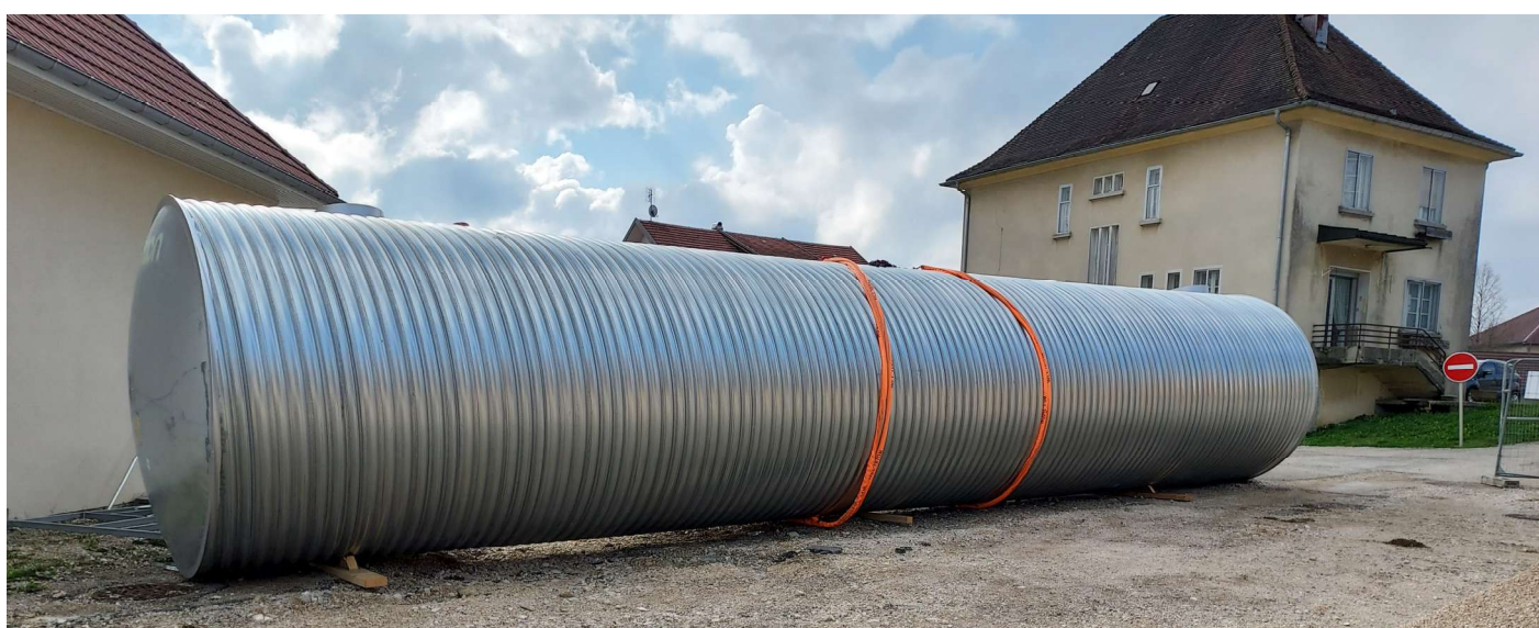
Cuve de stockage des eaux pluviales
