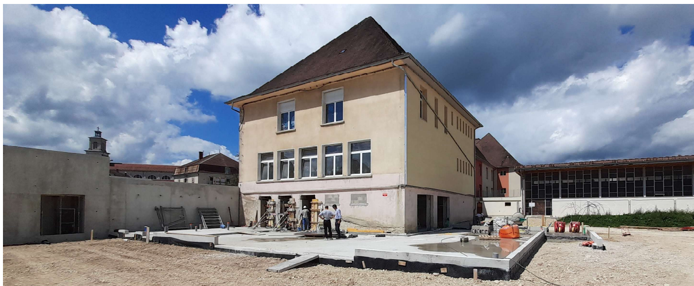
Photo prise avant le démarrage des travaux côté gymnase
