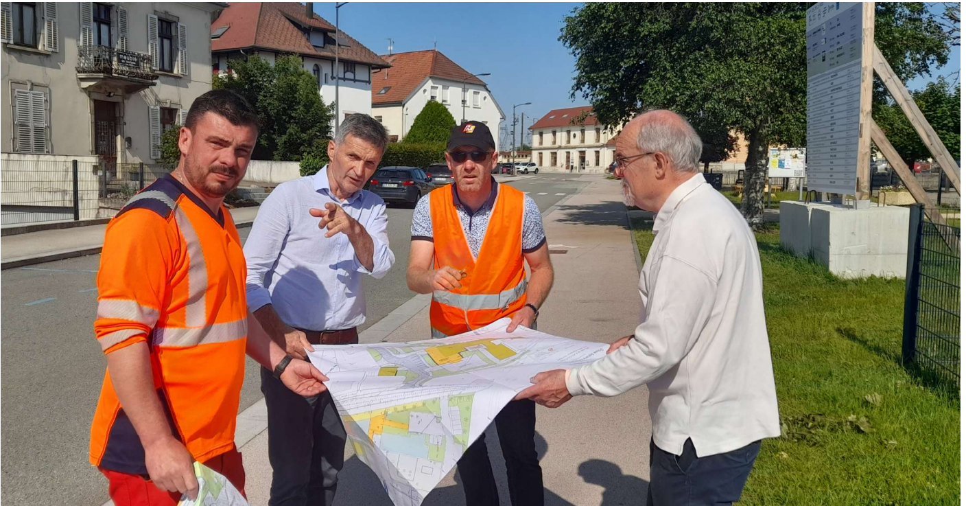
Réunion de chantier le 19 Juin 2023 au multi-accueil
