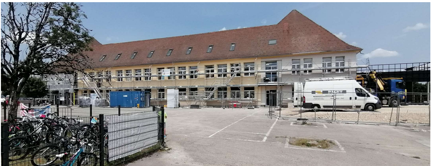
Chantier le 29 Juin 2023
