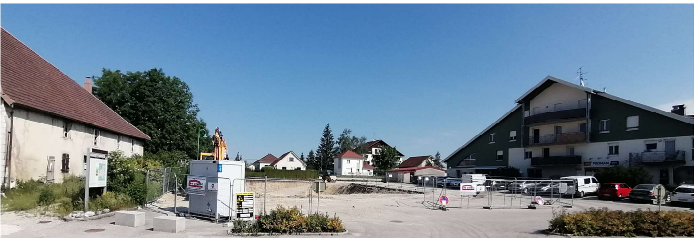
Démarrage des travaux sur la Place Rouy pour accueillir la maison de santé
