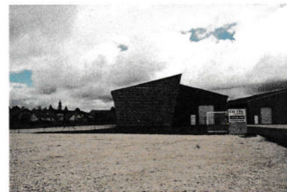
Plate forme en- treprise CGTEC 107.000€
