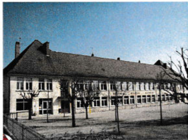
Travaux dans les écoles 543.000 €
