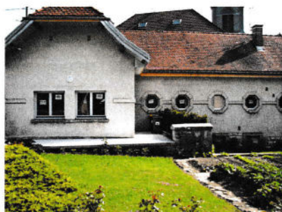
Travaux salle du 3e âge et presbytère 280.000 €
