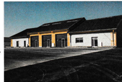
Bâtiment relais Pépinière d'entreprises 567.000€
