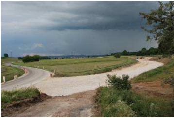
Les travaux de la RD9 au pont de « Casse-Cul »
