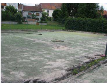
Les terrains de tennis avant travaux.
