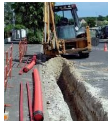
Enfouissement des fourreaux de fibre optique
