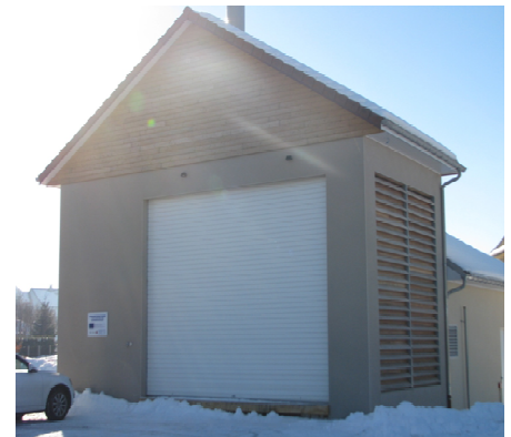
le silo de stockage peut contenir 120m3 soit environ 40T de plaquettes
