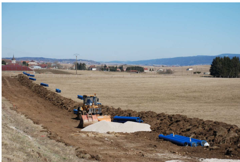
La conduite d'eau principale qui alimente notre village longe désormais la RD471
