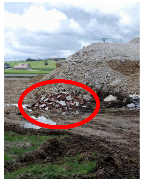
Dépôt sauvage de débris de démolition
