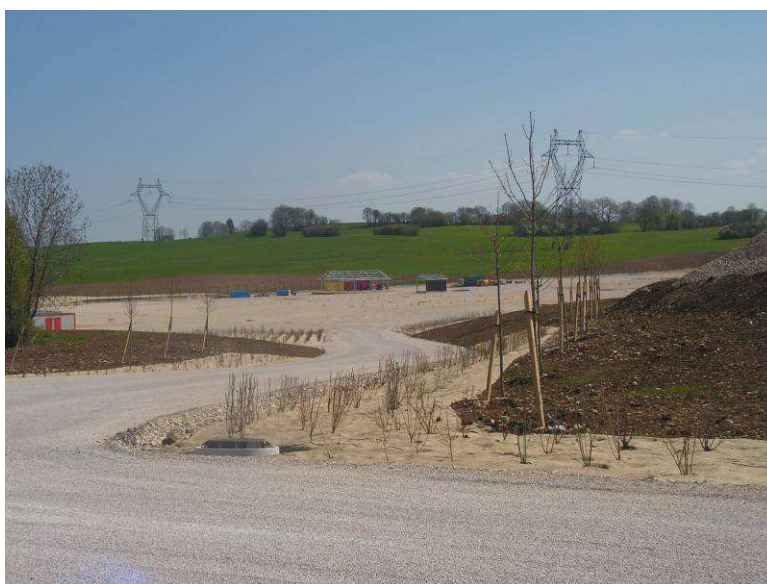
Une première vue de l'aménagement de la plate forme RTE
