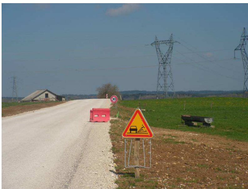
L'accès à la ferme de Cessay enfin réaménagé.
