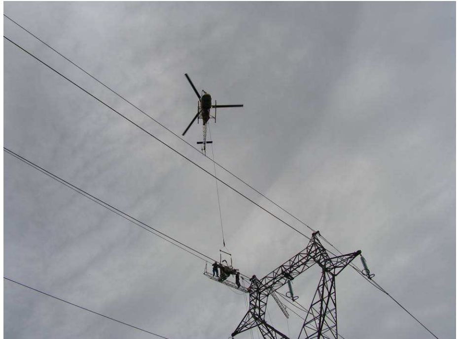
L'hélicoptère dans le ciel de Frasne pour l'installation de la fibre optique.
