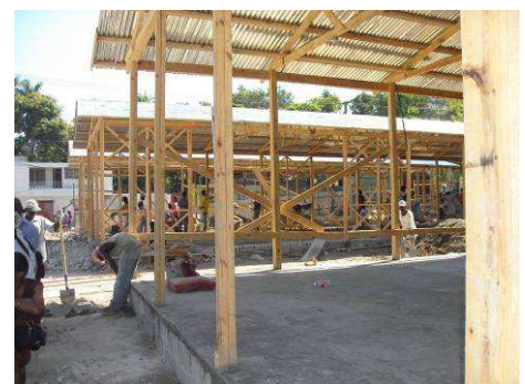
Construction d'une nouvelle école.
