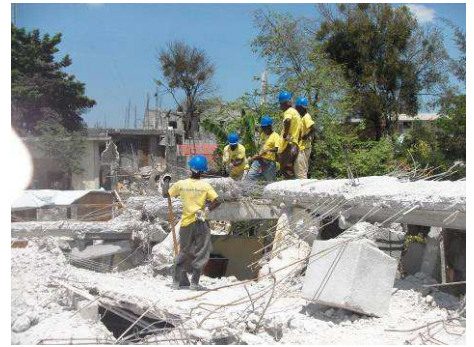
Déblaiement avant tout autre projet.
